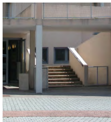
Escalier à repérer
