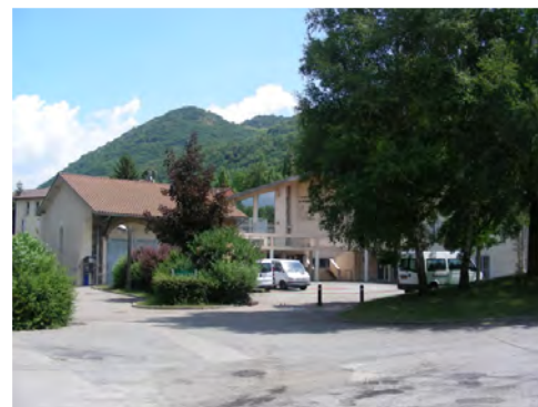
Pas de signalétique d'entrée du site
